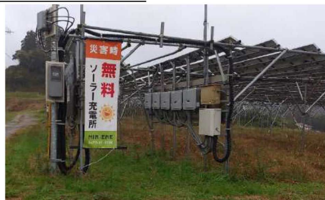
旗を掲出し、災害時に無料充電所として活用できることを地域に周知
