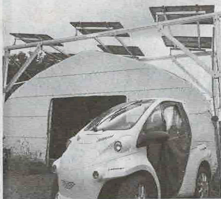
千葉エコ・エネルギーは災害時に備え太陽光パネルを新設した(千葉市)
